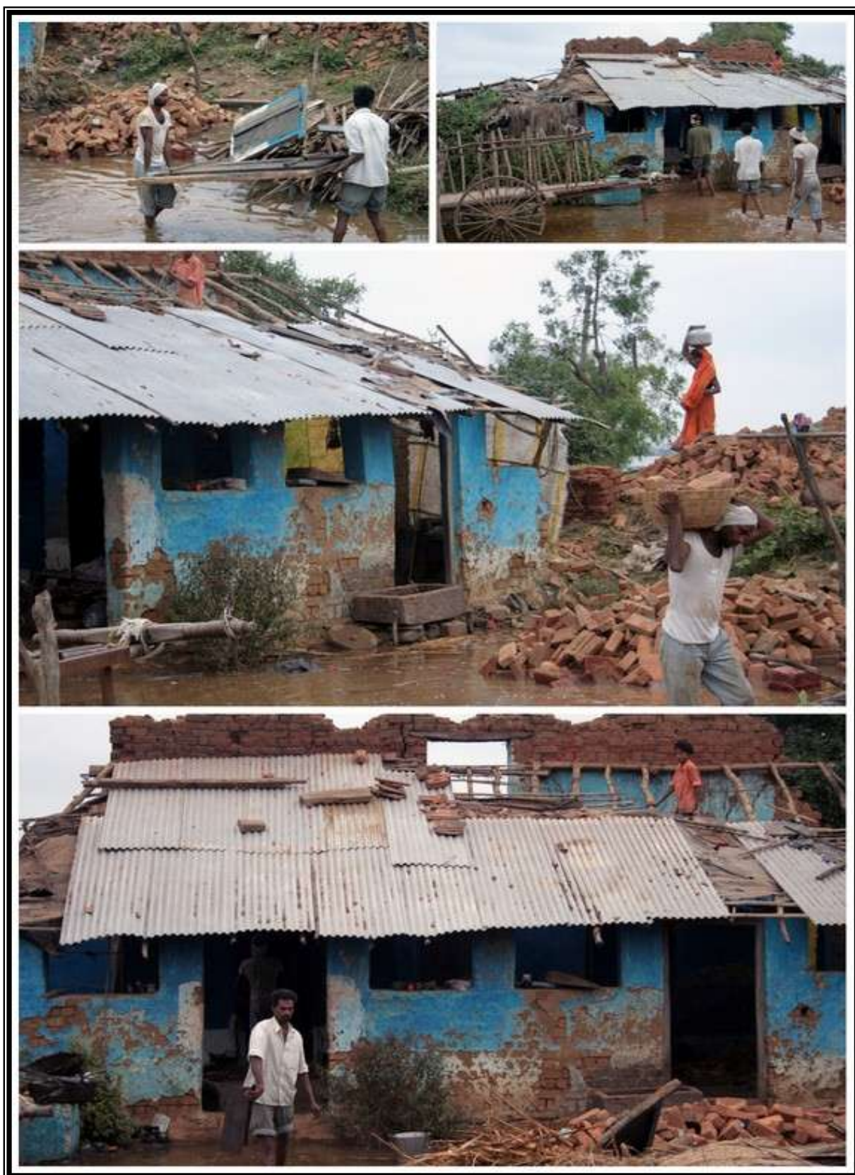
Figure n°1 – Le désossage du bâti dans l'urgence | déplacement du village de Gadeghat en novembre 2010
